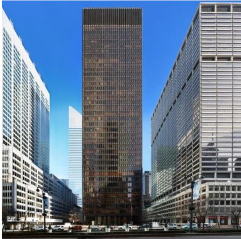
Figura 39. Arranha-Céu Seagram, em Nova York, terminado em 1958. Apenas no pós-guerra os projetos mais titânicos de Mies puderam ser executados. Nota-se novamente a estrutura metálica formando a divisória das janelas, que são longos painéis de vidro. Fonte: Vitruvius, foto de Victor Hugo Mori, 2018. <https://vitruvius.com.br/revistas/read/arquitetismo/15.170/8165>, acessado em 04/07/22
