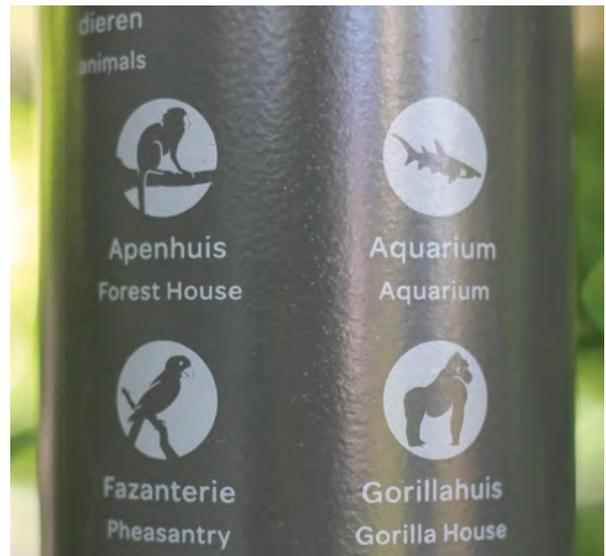
35 e 36. As placas eram feitas em chapas de aço galvanizado, com pintura e aplicação de silk-screen.
