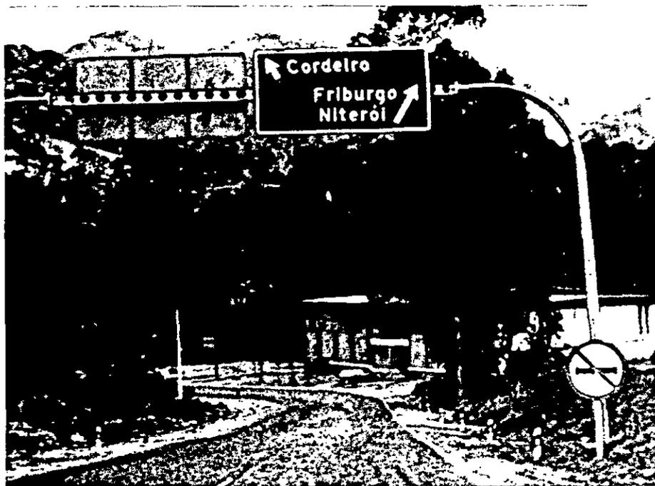
As placas, quando colocadas lateralmente à estrada, devem formar um ângulo de  $90^{\circ}$  à  $95^{\circ}$  com direção e sentido do fluxo.
