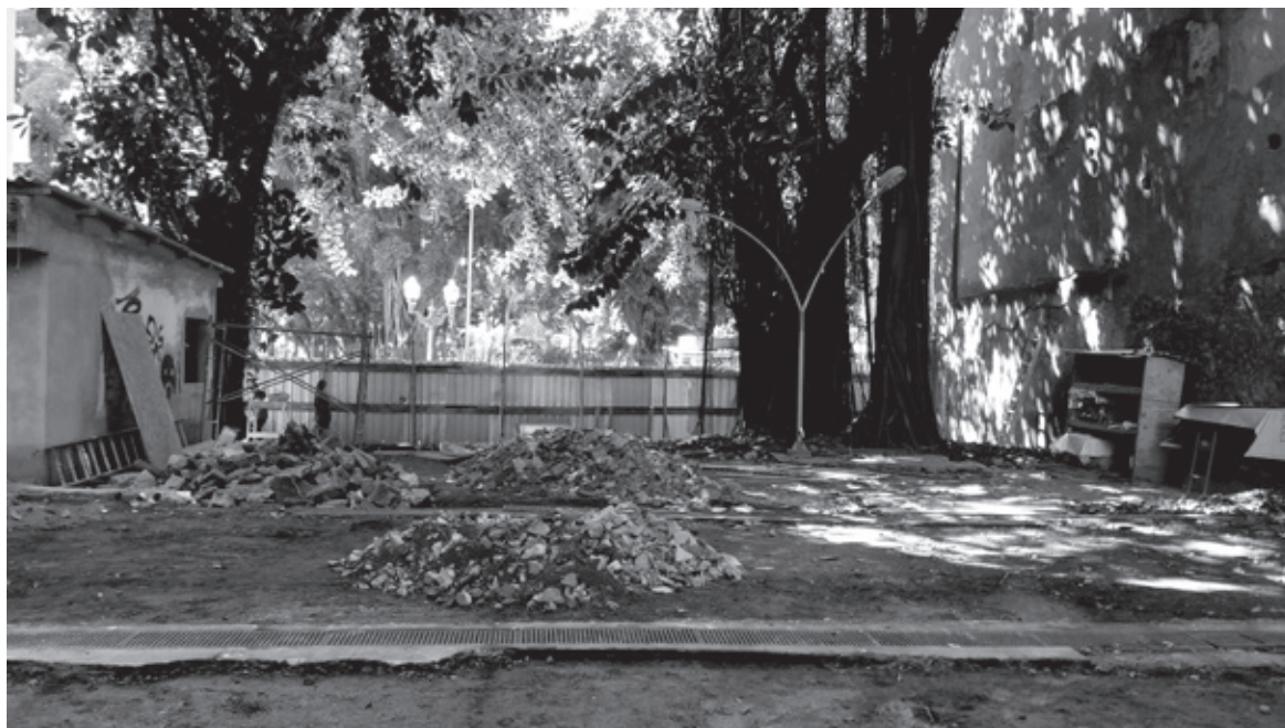
Figura 4.5 Parte do terreno da escola, durante a construção do novo portão com acesso pela Rua do Passeio [Esdi, 2017] (Zoy Anastassakis).
