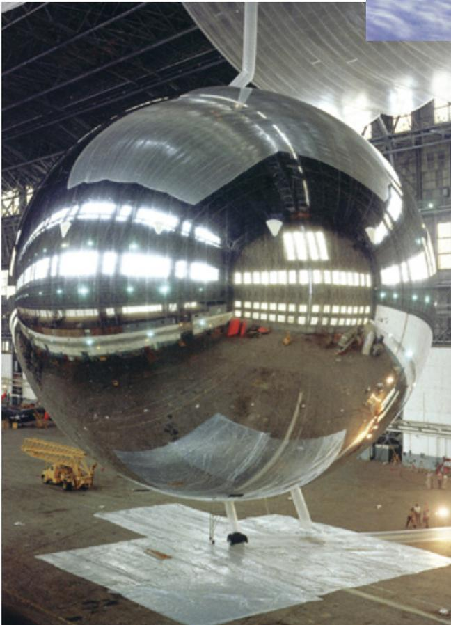
165 - Teste do primeiro satélite artificial comercial, o Echo I em 1960. O aparelho consistia de uma imensa esfera inflável de Mylar, um filme de poliéster metalizado da DuPont. Notar a escala pelo caminhão e pessoas ao redor.
