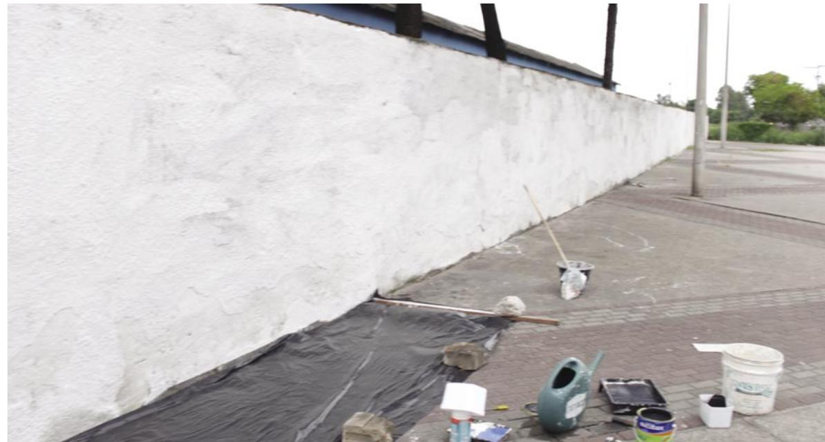
Por causa das condições físicas do muro, precisou-se fazer uma base de cal, em torno de 14 litros, para que, ao aplicar a tinta, o muro não a absovesse, resultando num tom de branco meio transparente. Rapidamente, o cal criava uma camada de impermeabilidade e já dava uma base branca, facilitando a pintura posterior.
