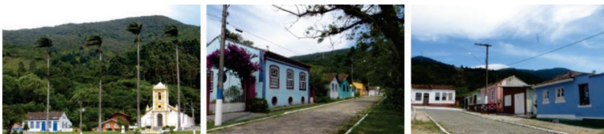
Figura 9 - Vistas do entorno da praça da Enseada de Brito: à esquerda, a Casa da Cultura Açoriana de Palhoça e a Igreja Nossa Senhora do Rosário. Ao centro e à direita, amostra do casario remanescente. Fonte: acervo do projeto (2016).
