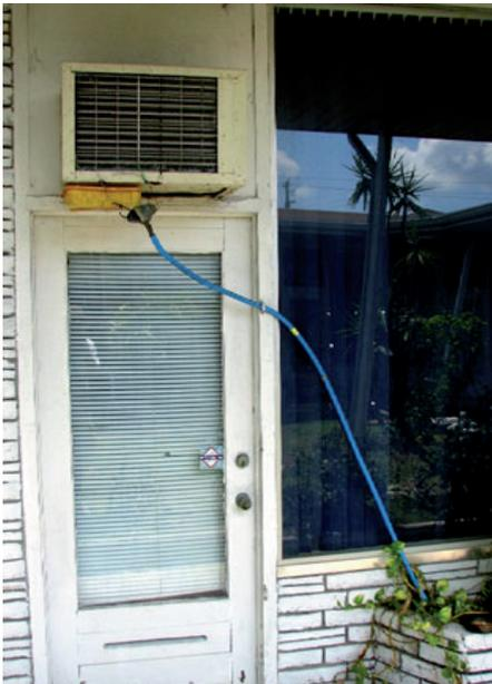
Imagem 116 - A água que cai do aparelho de ar-condicionado vai direto irrigar a planta.
