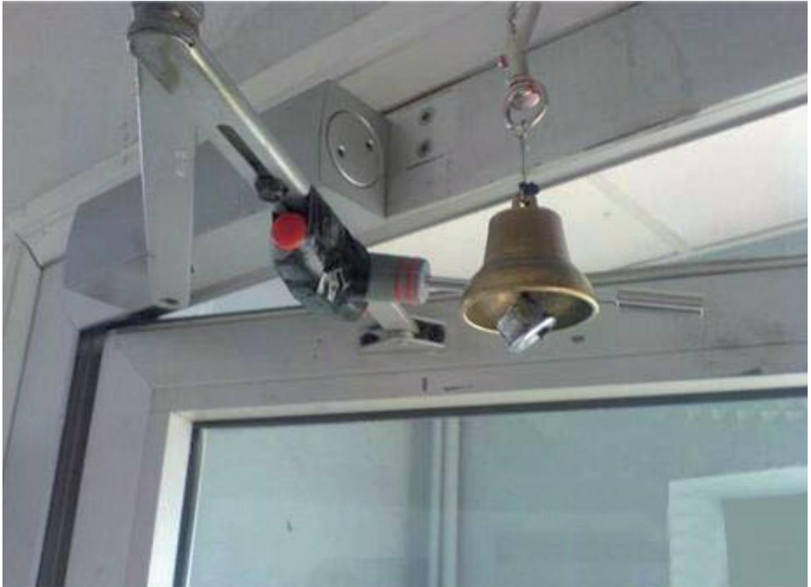
Imagem 18 - Ferramenta multifuncional utilizada como alternativa para reparar o sistema de fechamento automático da porta.
