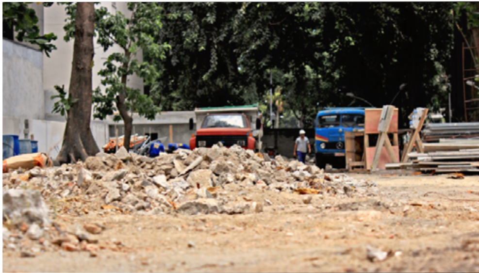
Figura 7: Canteiro de Obras
