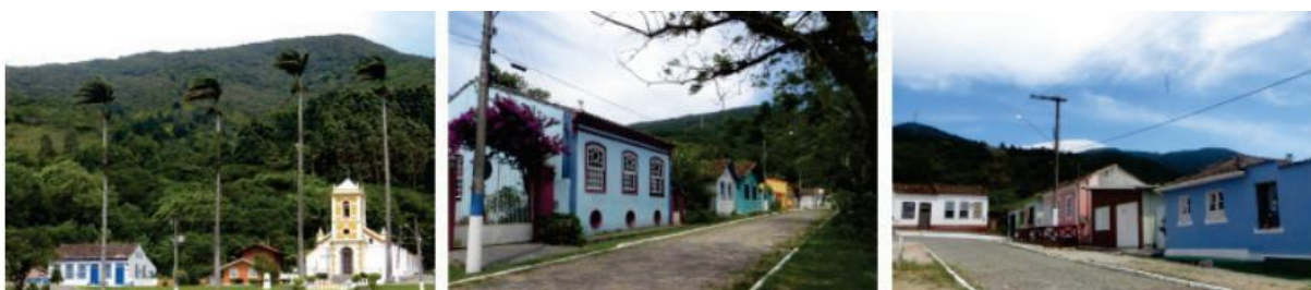
Figura 12 - Vistas do entorno da praça da Enseada de Brito: à esquerda, a Casa da Cultura Açoriana de Palhoça e a Igreja Nossa Senhora do Rosário. Ao centro e à direita, uma amostra do casario remanescente.
