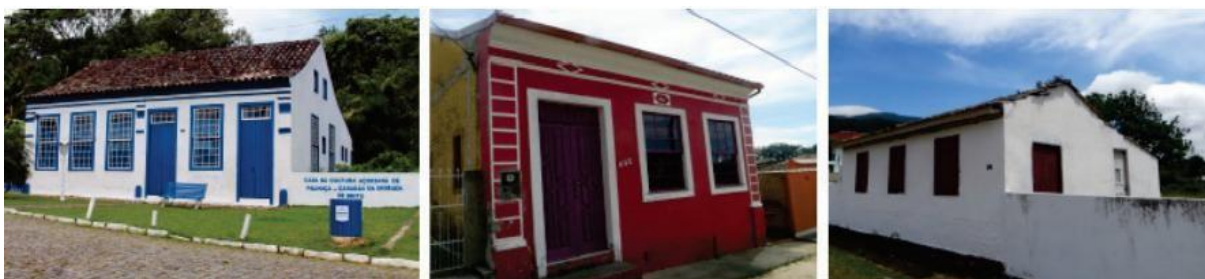
Figura 15 - Amostra do casario remanescente na Enseada de Brito: à esquerda, a Casa da Cultura Açoriana de Palhoça. Ao centro, residência com epígrafe arquitetônica do ano de 1850. À direita, a casa conhecida como a primeira escola da região.
