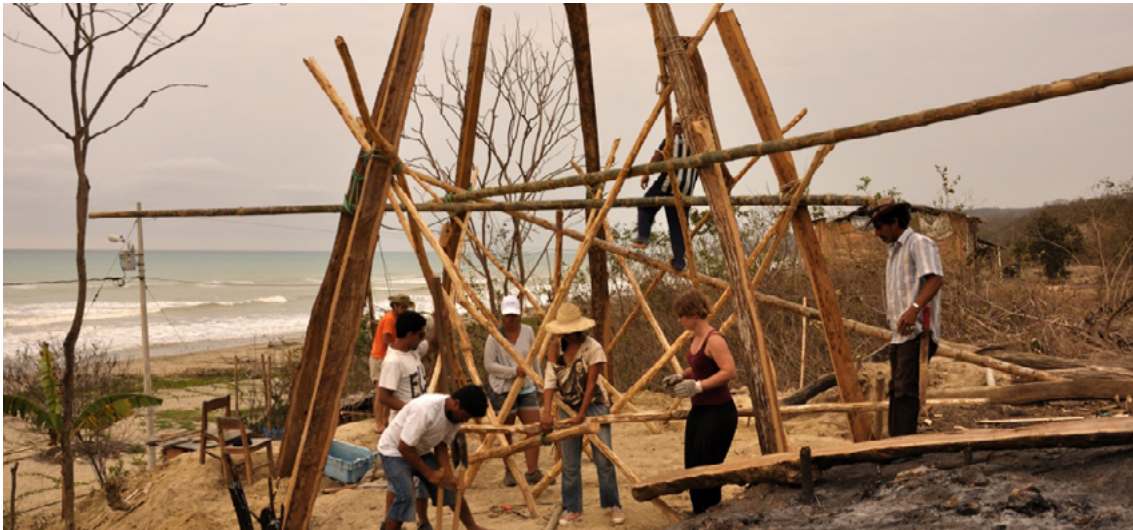
FIGURA 5. Proceso de construcción – Última Esperanza ©Al Borde
